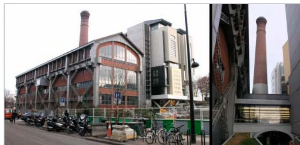
Pařížská fakulta architektury sídlí v bývalé výrobě stlačeného vzduchu
