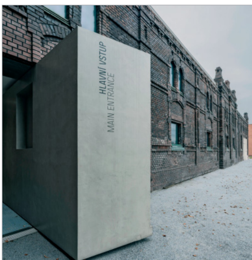
Konverze ostravských městských jatek na galerii Plato – otočná stěna hlavního vstupu s mikrocementovou povrchovou úpravou (Studio KWK Promes, projekt 2017, realizace 2020–2022)
