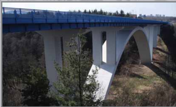
Obloukový most na D6 přes Ohří u Lokte (délka 296 m, šířka 13 m, rozpětí vetknutého oblouku 123 m, vozovka je 55 m nad údolím; autor: Jaroslav Korbelař; Cena ČKAIT 2010)
